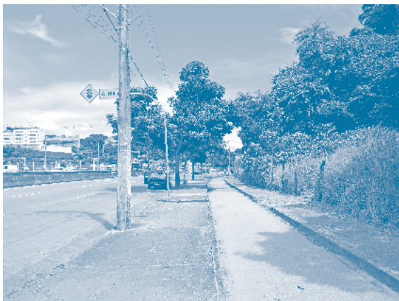
Figura 6 (a e b): Urbanização de áreas lindeiras do Ribeirão Arrudas no âmbito do Prosam. a – Ciclovia ao longo da av. Teresa Cristina. b – Área de lazer cercada, com quadras e academia a céu aberto na av. Teresa Cristina. Fonte: registros da autora, 2019.
